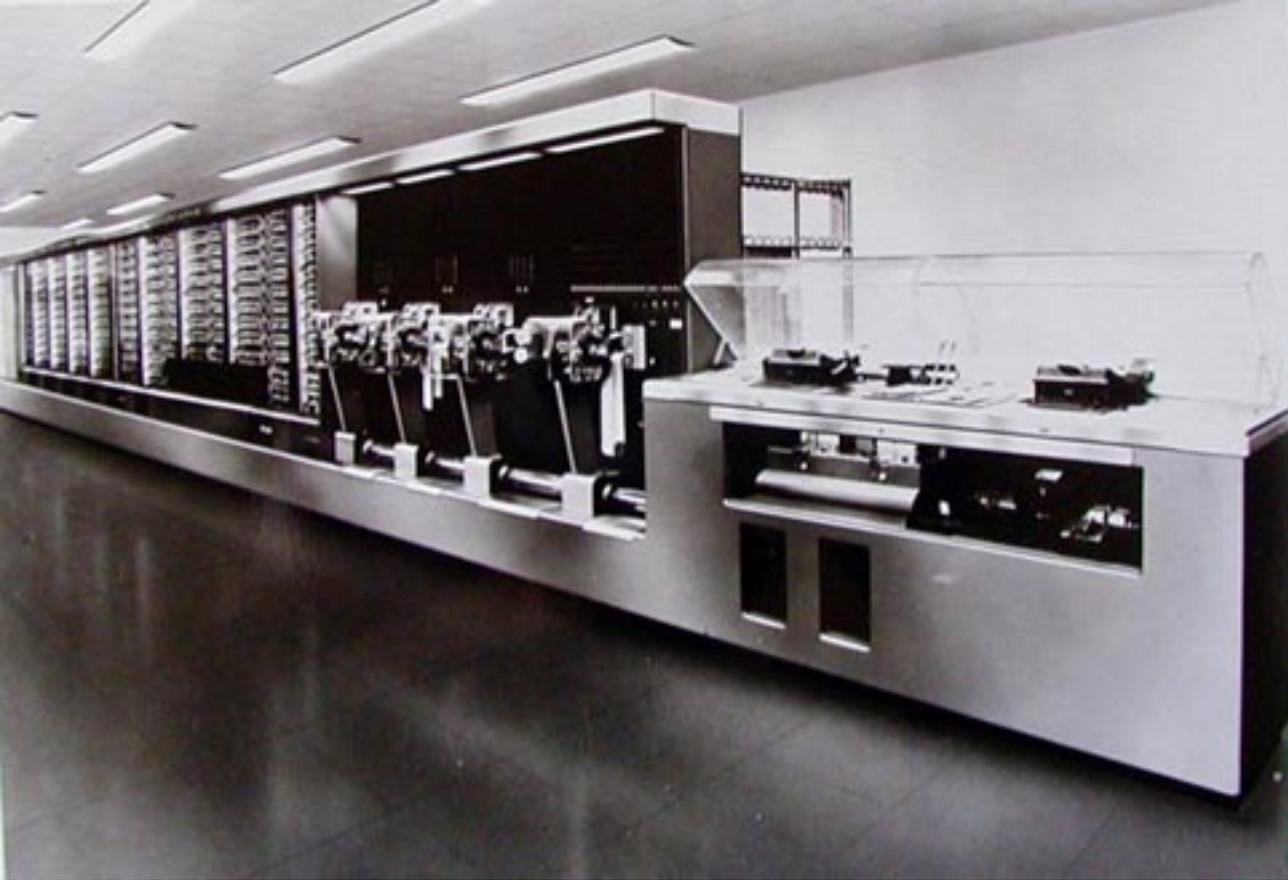
1943 : création du IBM ASCC Mark I (Automatic Sequence-Controlled Calculator Mark I) à Harvard par Howard Aiken et son équipe (3000 relais, 800 km de câbles). Il permet de faire 3 opérations sur 23 chiffres par seconde.
