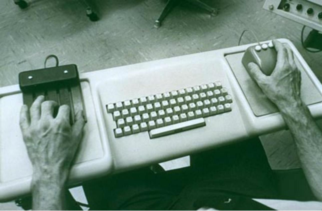
1968 : la console de travail ergonomique du système NLS (oN-Line System) conçu par Douglas Engelbart, permettant à plusieurs personnes de travailler en réseau dans un environnement comprenant déjà des fenêtres et un système hypertexte, ici avec une souris et un «keyset».
